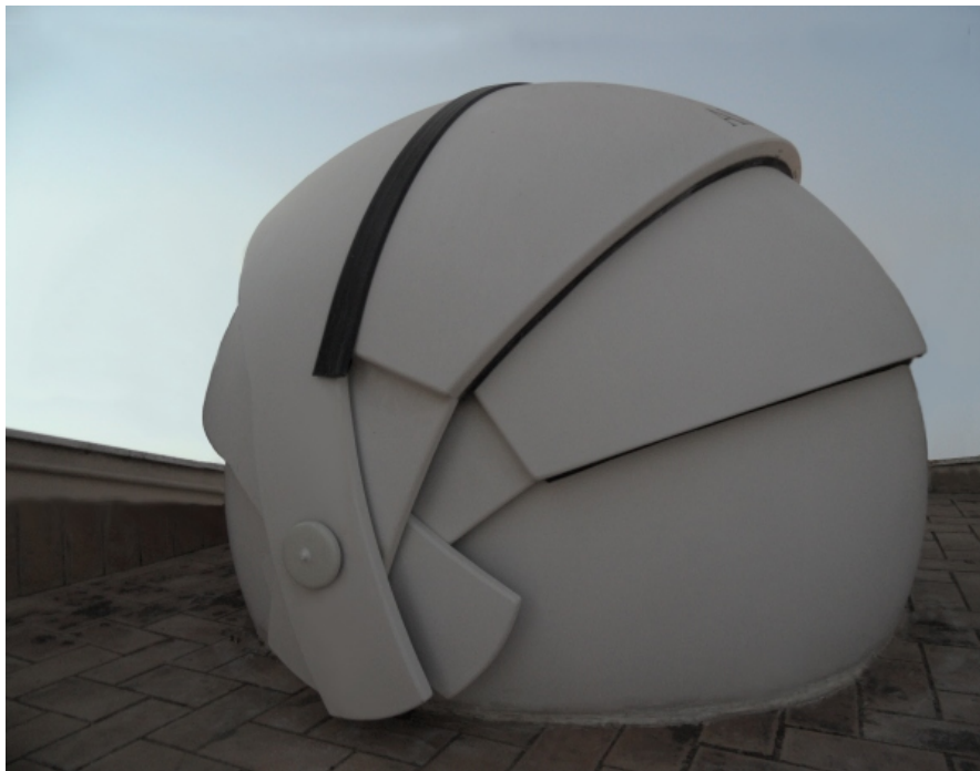
Figura 3.2. Cúpula tipo "clamshell" en la que se ubica uno de los telescopios C14 operados desde Sevilla.
